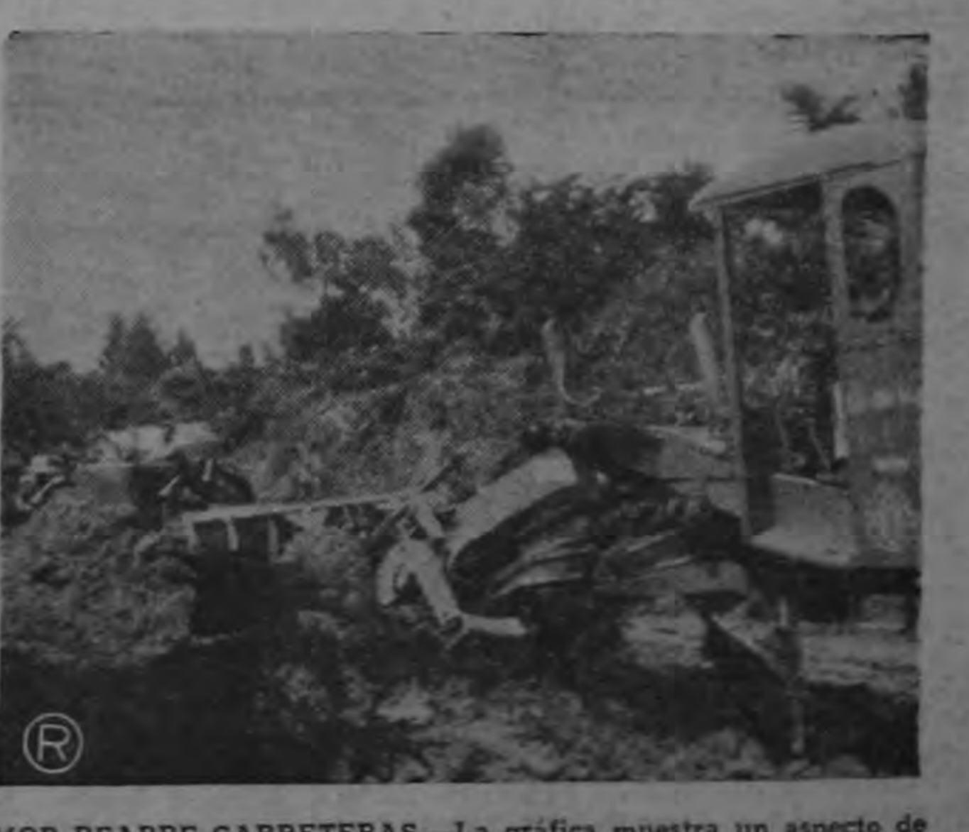
MOP REABRE CARRETERAS. —La gráfica muestra un aspecto de la reapertura de la carretera que se está efectuando con ayuda del equipo de Obras Públicas, en el tramo comprendido entre Aserrí y Vuelta de Jorco.
